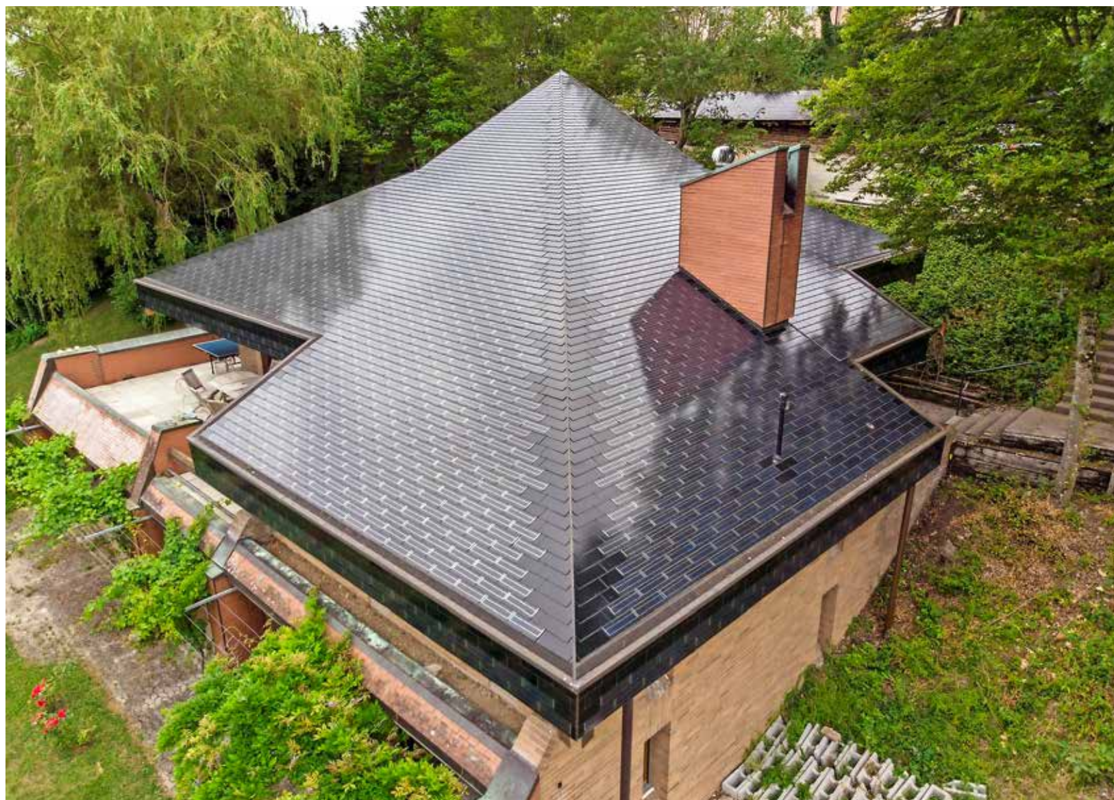
Construite par un élève de le Corbusier, cette villa du village de Colombier (VD) est recouverte de tuiles solaires. DR
